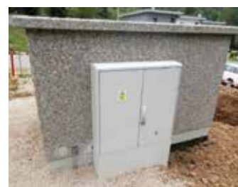
Obrázok 3. NN rozvádzač pre automatizáciu pri kioskovej DTS
