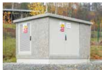
Obrázok 3. NN rozvádzač pre automatizáciu pri kioskovej DTS
